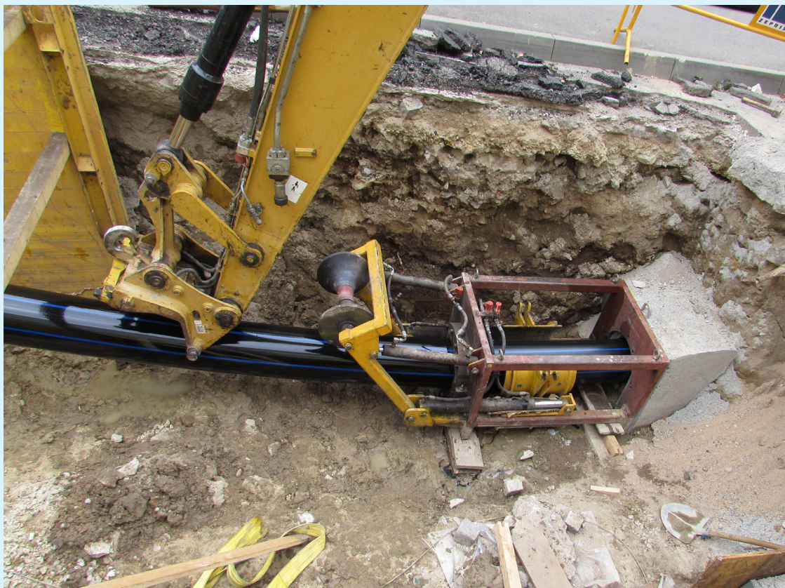
● Obnova vodovodu DN 300 Mělník, ul. Vodárenská.
