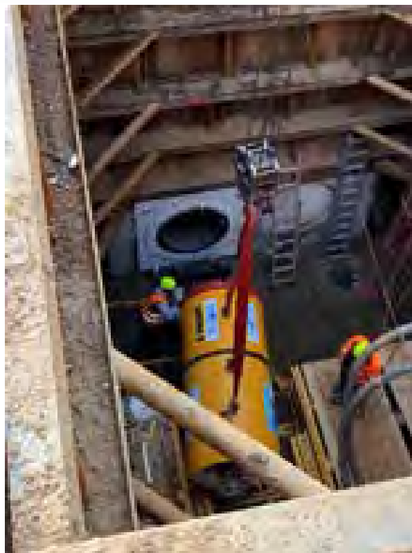
▪ Razící štít při rekonstrukci vodovodní shybky pod řekou Labe u Obříství.
